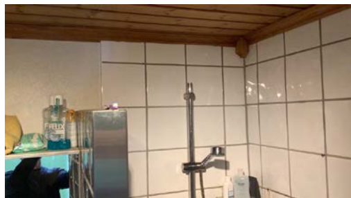
Det er uegnede materialer i den definerte våtsonen rundt dusj.
