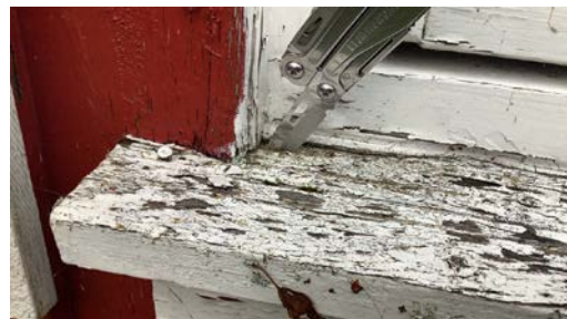
Råteskadet vannbrett.
