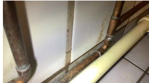
Sprang mellom veggfliser.
