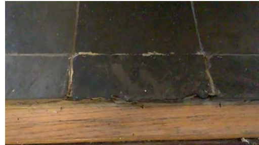
Sprang mellom gulvfliser i spisestue.
