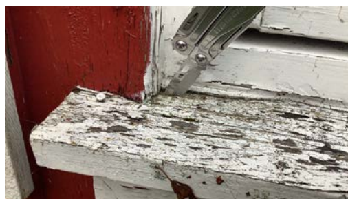
Råteskadet vannbrett.
