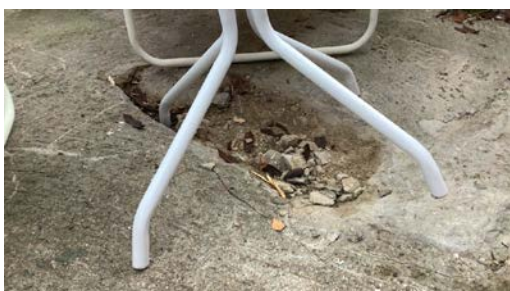
Sprekkdannelse i betongplate.
