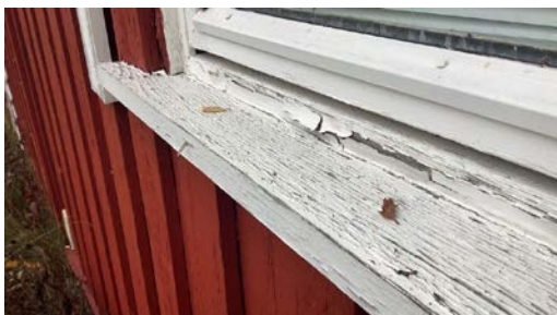
Vannbrett med fall mot vindu.
