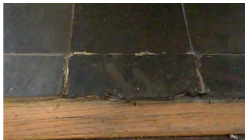
Sprang mellom gulvfliser i spisestue.
