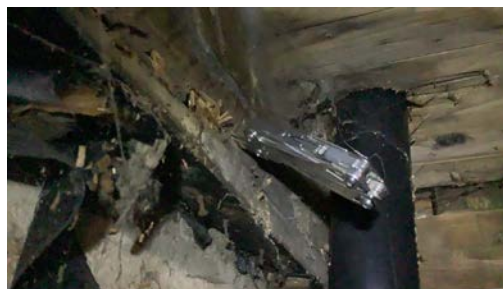
Råteskadet gulvbjelke.
