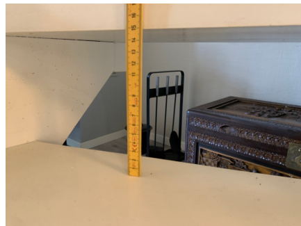
For stor avstand mellom trinnene
