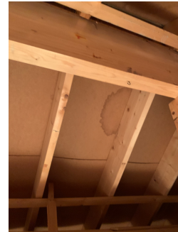
Sperrekonstruksjon med synlig limtreddrager i møne
