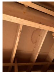
Sperrekonstruksjon med synlig limtredrager i møne
