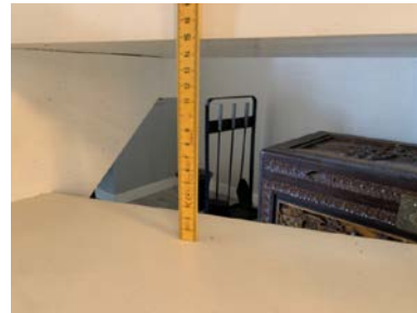
For stor avstand mellom trinnene
