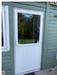
Terrassedør med malt treramme
