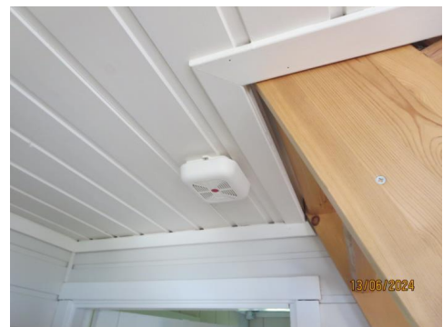
Bilde tatt mot ene brann melder som er montert ved trapp opp til ene hems rom.
