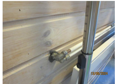
Bilde tatt mot rør føringer gjennom vegg inn til baderoms innredningen
