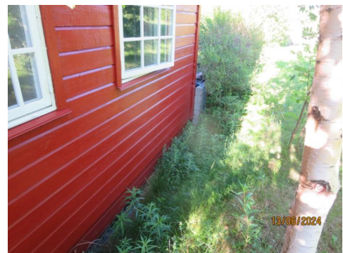
Bilde viser kledning gavl side mot vei, ført ned mot terrenget
