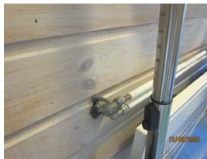
Bilde tatt mot rør føringer gjennom vegg inn til baderoms innredningen
