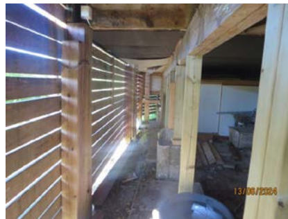
Bilde viser deler av kryp rommet under hytta hvor det er størst høyde
