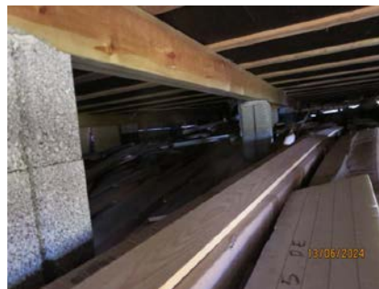
Bilde viser deler av kryp rommet under hytta
