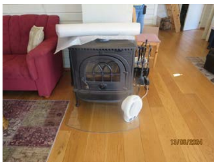
Bilde tatt mot ved- fyrte peis ovenn m/ glassplate under
