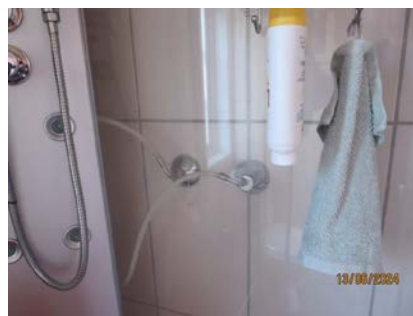
Vann tilkobling for dusj kabinettet i plast
