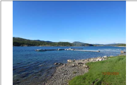
Bilde tatt fra sjøsiden ved naustet mot nyetablerte bryggeanlegget
