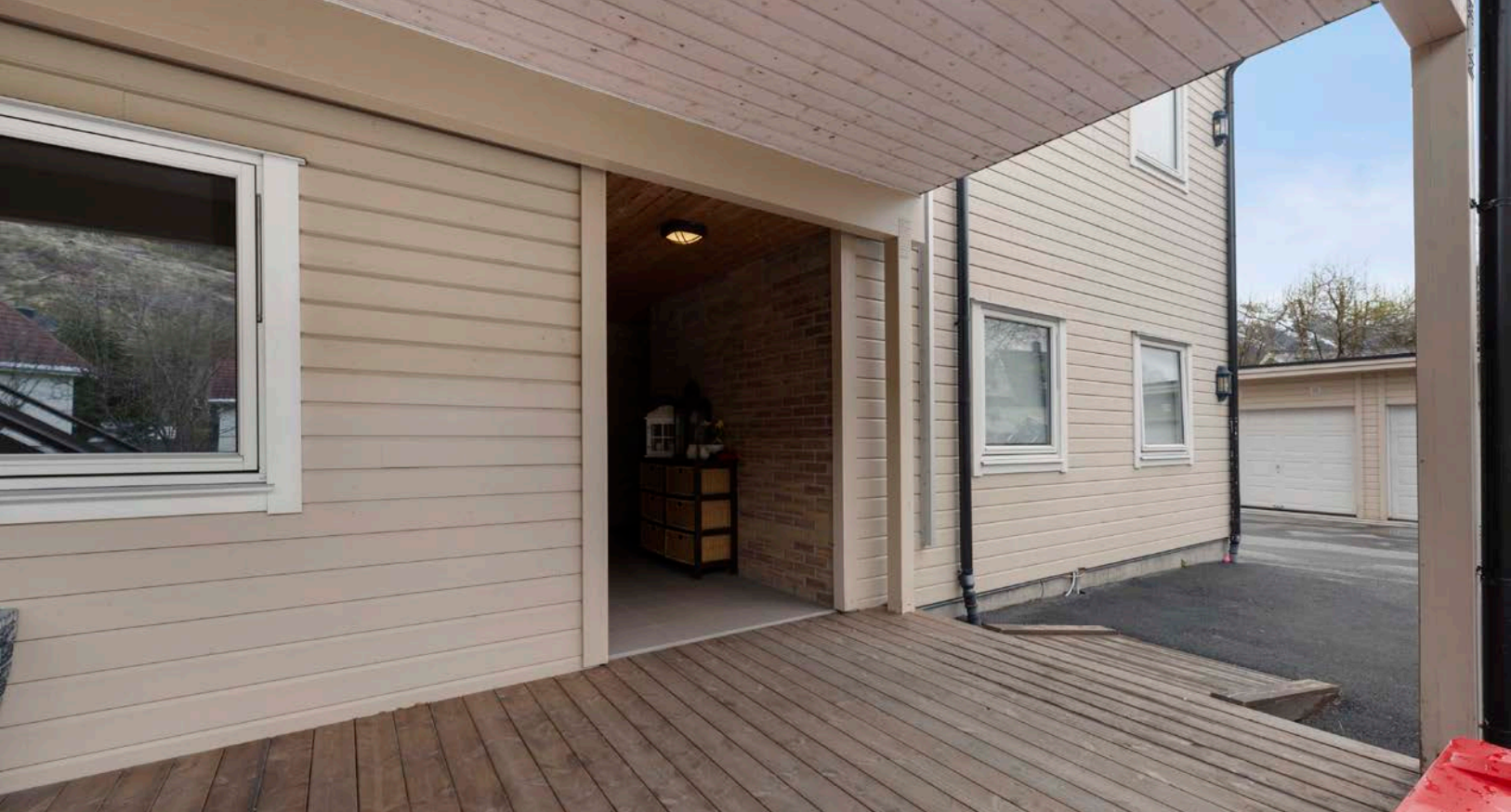
Terassen utenfor to av leilighetene i 1.etg.
