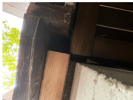
Åpent opp bak kledningen.
