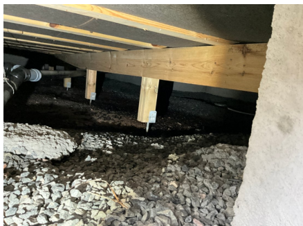
lavere terreng under bygget.
