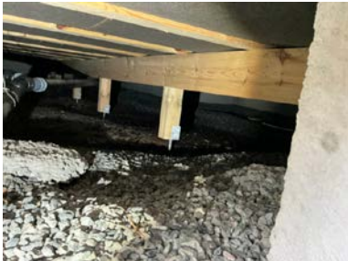
lavere terreng under bygget.
