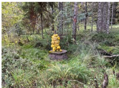
Vannpost i området.
