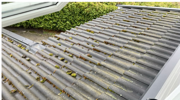
Det mangler snøfangere over inngangspart
