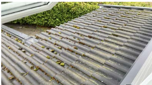
Det mangler snøfangere over inngangspart
