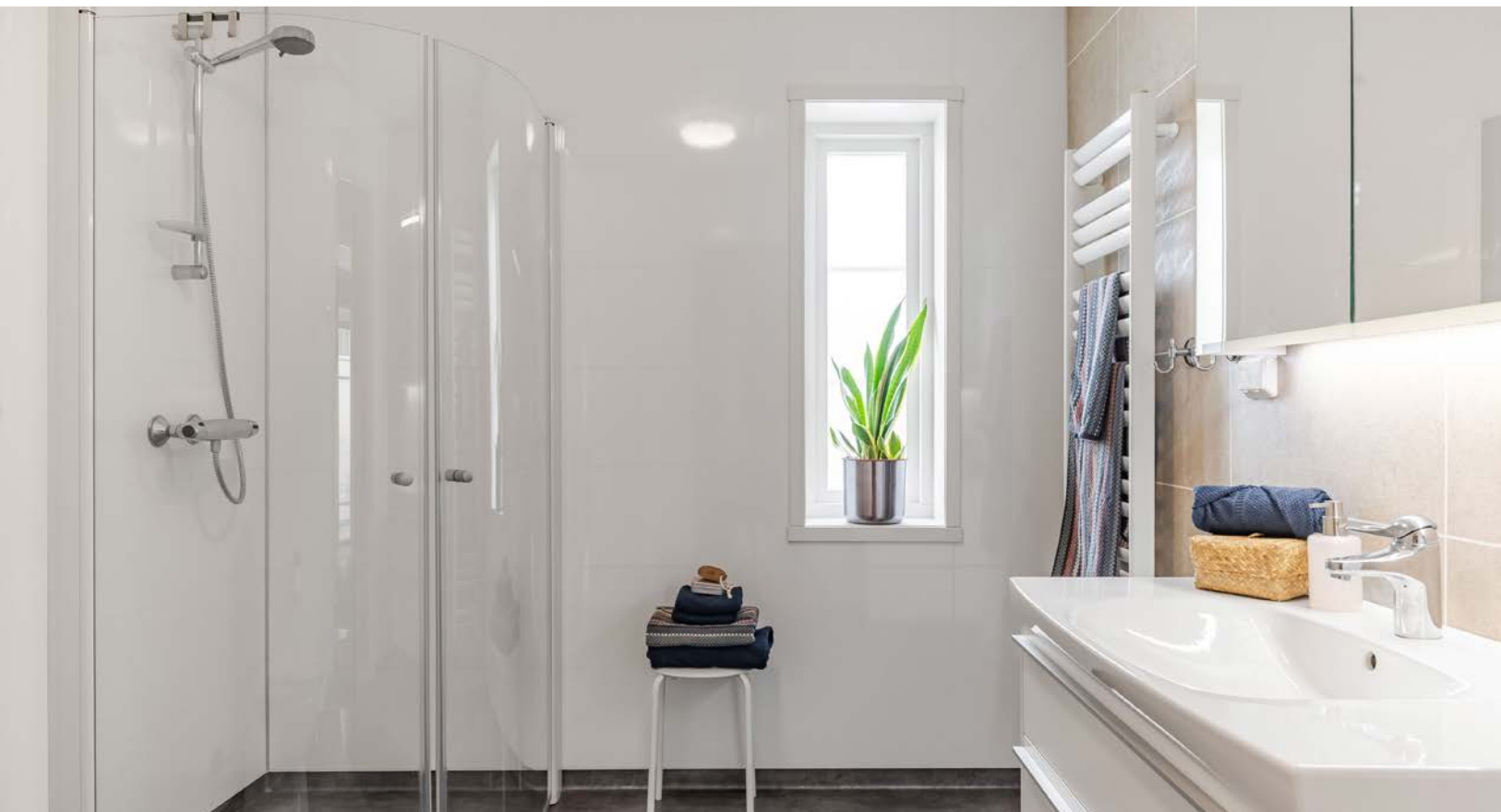
Lyst og moderne baderom 1 fra byggeåret 2022. Badetrommet har våtromsbelegg på gulv, lyse våtromsplater på veggene og avtrekk via balansert ventilasjon.
