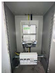
Sikringsskap med automatsikringer.
