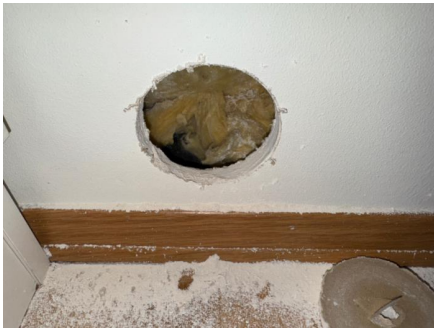
Hulltaking i tilstøtende soverom
