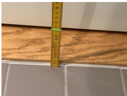
Fallforhold ca. 104 mm overkant gulv ved terskel
