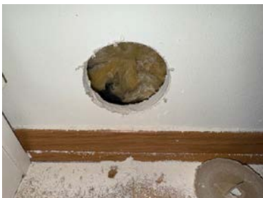
Hulltaking i tilstøtende soverom
