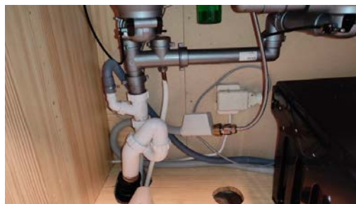
Kontroll etter lekkasjer.
