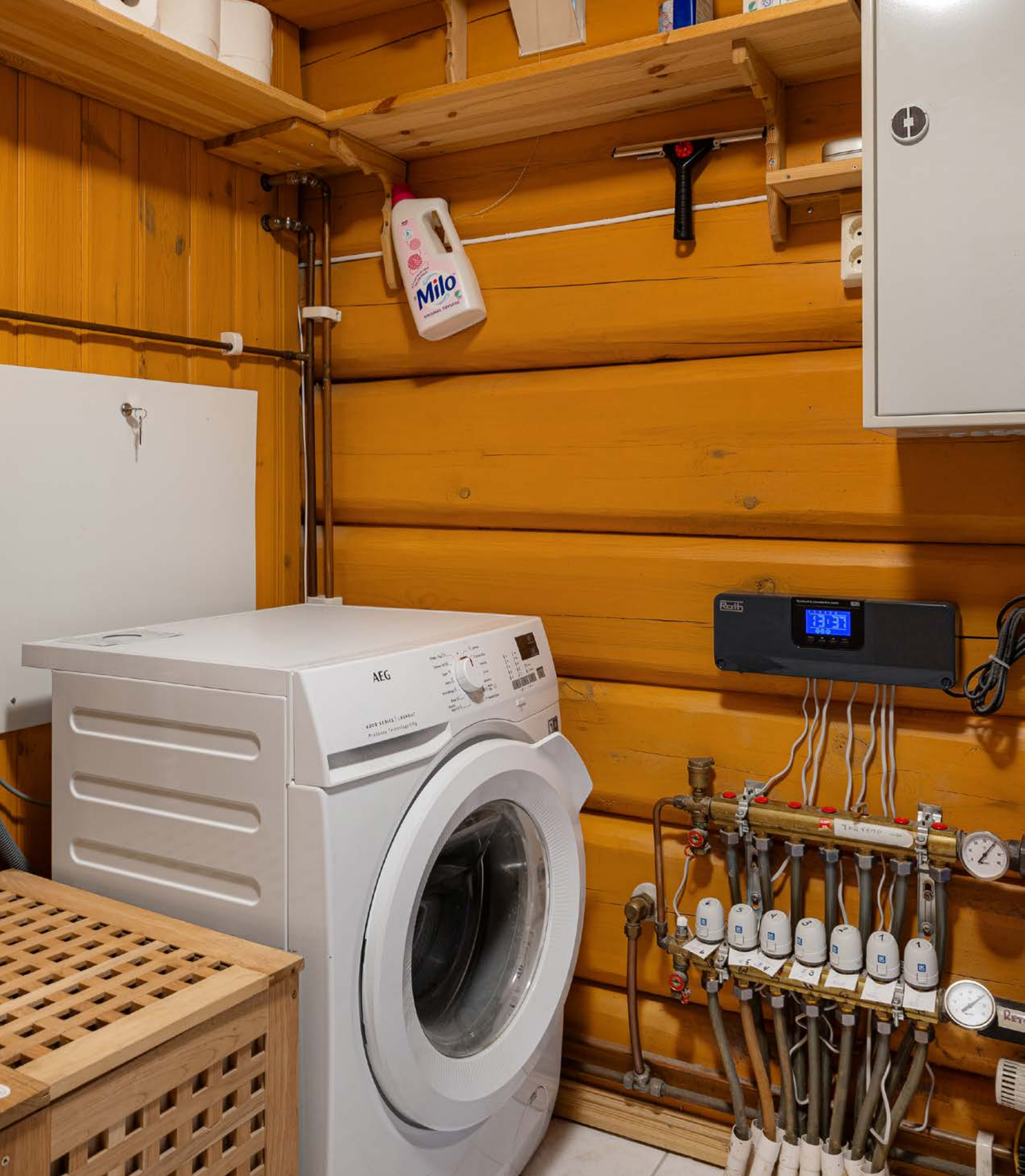
Vaskerommet har samme type overflater som badet.
