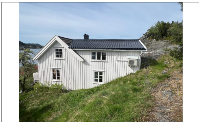
Bilde tatt på befaring 29/4.2025.
