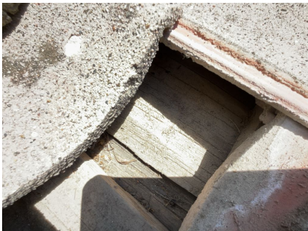
Del av takkonstruksjon, under takstein.
