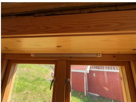
Eksempel på montert ventil i vindu.
