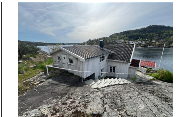
Bilde tatt på befaring 29/4.2025.
