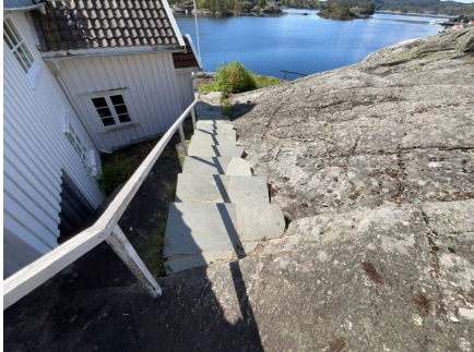
Trapp mellom terreng.
