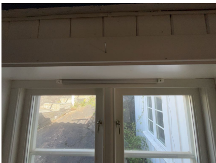
Eksempel på montert ventil i vindu.
