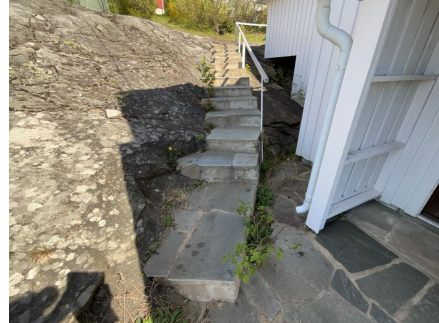
Trapp mellom terreng.
