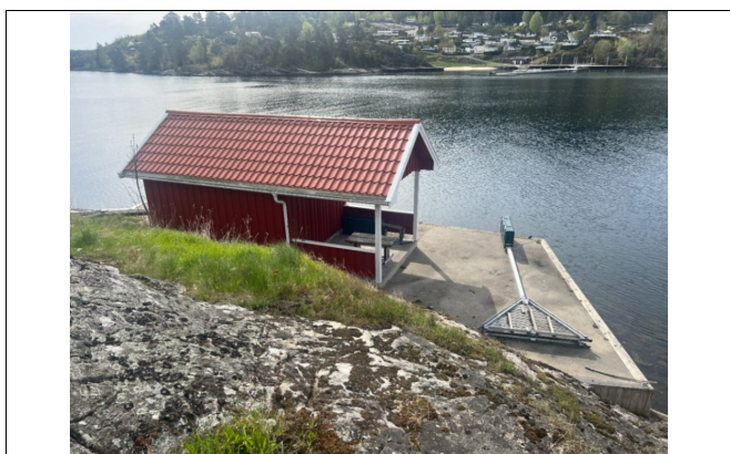
Bilde tatt på befaring 29/4.2025.
