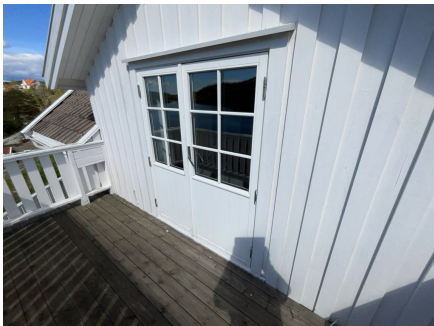
Terrassedør inn til 2 etasje.
