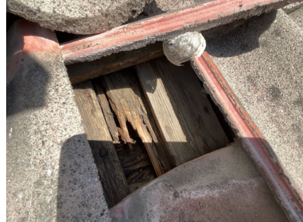
Del av takkonstruksjon, under takstein.
