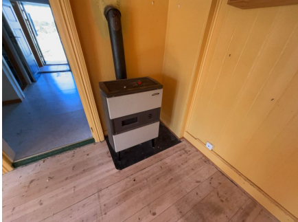
Montert ovn i stue.
