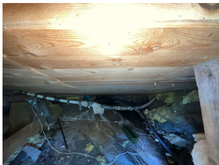
Del av etasjeskille sett fra undersiden.
