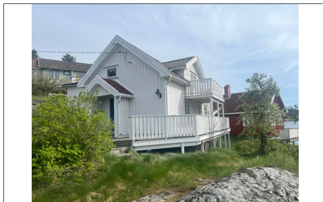
Bilde tatt på befaring 29/4.2025.
