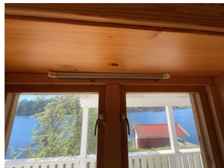
Eksempel på montert ventil i vindu.
