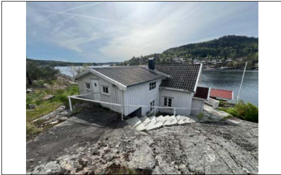
Bilde tatt på befaring 29/4.2025.
