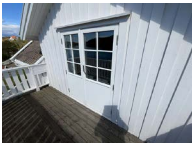
Terrassdør inn til 2 etasje.
