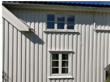
Eksempel på vindu i yttervegg.
