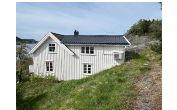
Bilde tatt på befaring 29/4.2025.
