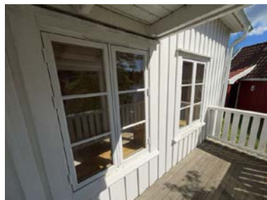
Eksempel på vindu i yttervegg.
