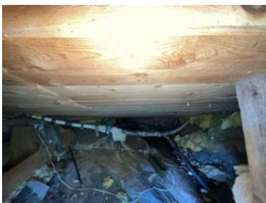
Del av etasjeskille sett fra undersiden.
