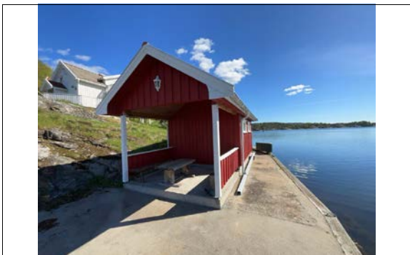
Naust ført opp på eiendommen.
