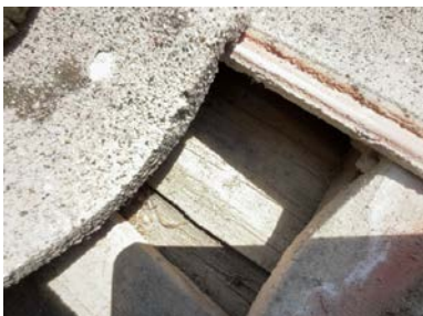
Del av takkonstruksjon, under takstein.
