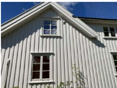
Eksempel på vindu i yttervegg.
