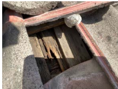
Del av takkonstruksjon, under takstein.
