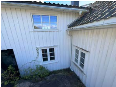
Eksempel på vindu i yttervegg.
