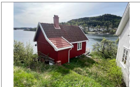
Bilde tatt på befaring 29/4.2025.
