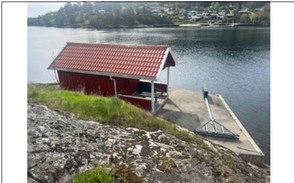
Bilde tatt på befaring 29/4.2025.
