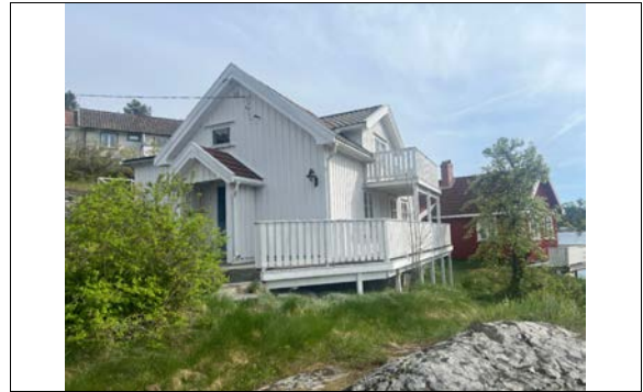
Bilde tatt på befaring 29/4.2025.
