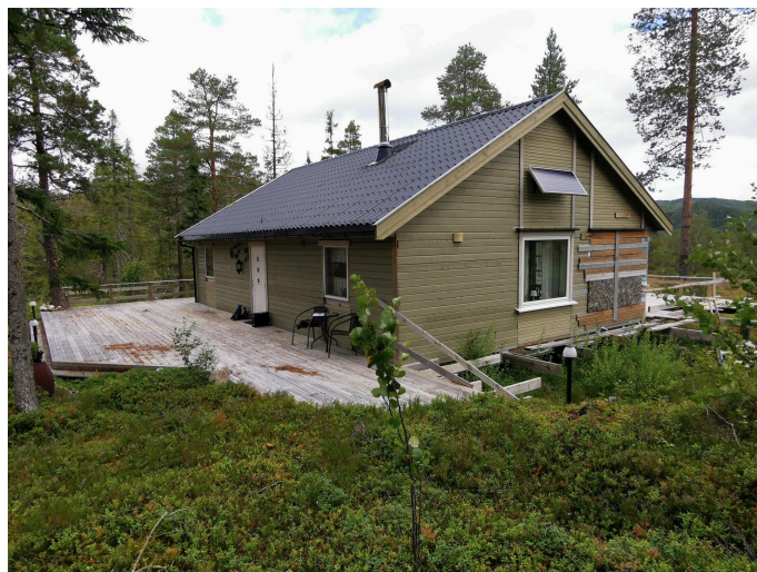
Manglende vindu på stue.
