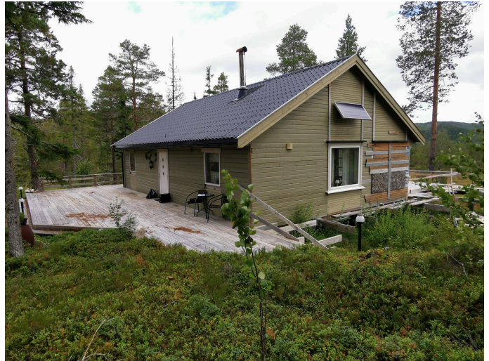
Manglende vindu på stue.
