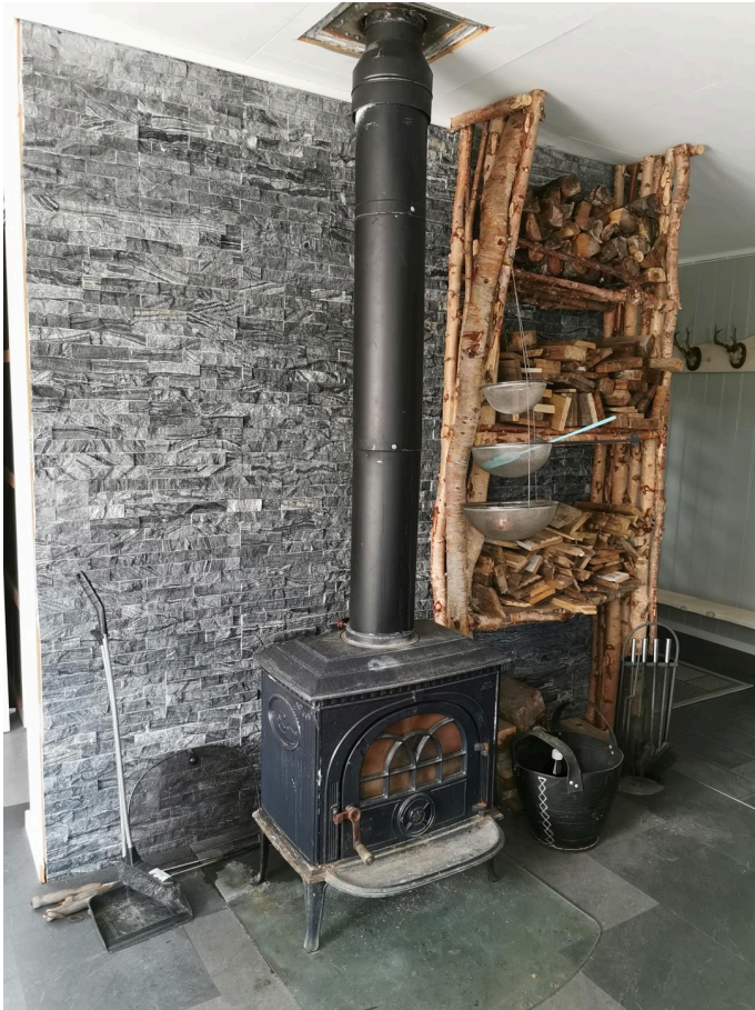
Bilde av eldre vedovn og isolert røykrør
