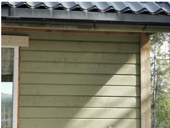
Mangler utstikk på takplater
