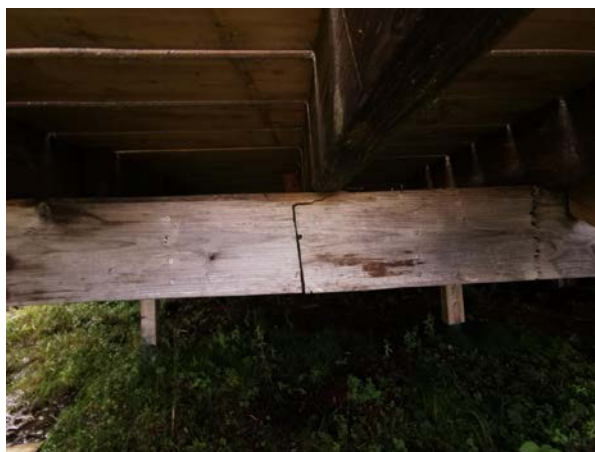
Brudd på tredrager under veranda Her ses materialer av uimpregnert virke på drager/trebjelkelag
