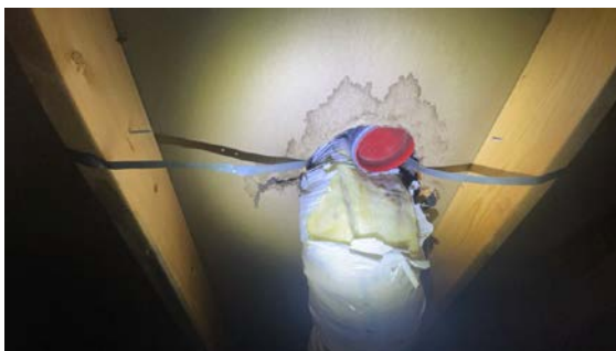
Skjolder ved luftehatt
