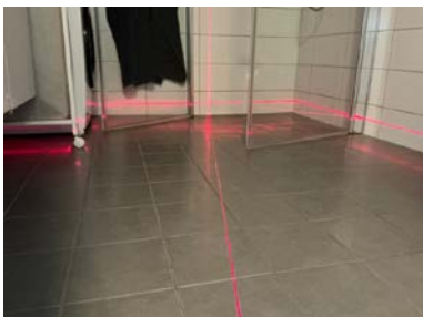
Fall på baderomsgulv er kontrollert med krysslaser.
