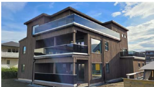
Terrasse oppført uten for fasade nordvest.
