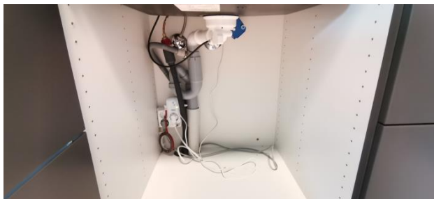
Kontroll av røropplegg under oppvaskkummen.
