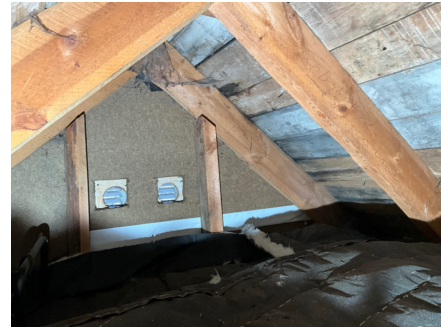
Lufting sammen med ytterveggene.
