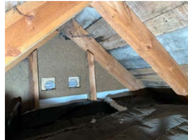
Lufting sammen med ytterveggene.
