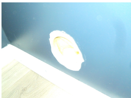
Hulltaking fra soverom mot dusjhjørne.
