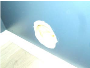
Hulltaking fra soverom mot dusjhjørne.
