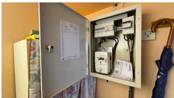
Kontroll av el-skap og kursfortegnelse.
