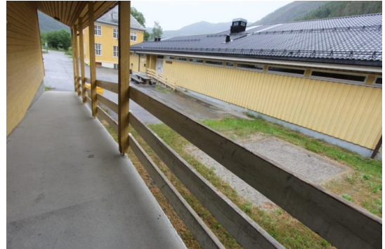
Betongstøpt rampe til hovedinngang.
