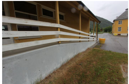
Betongstøpt rampe til hovedinngang.
