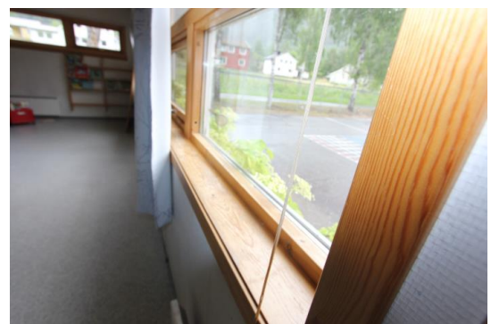
Innvendig vindu med foring.
