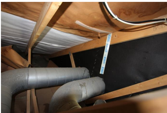
Takkonstruksjon med undertak.
