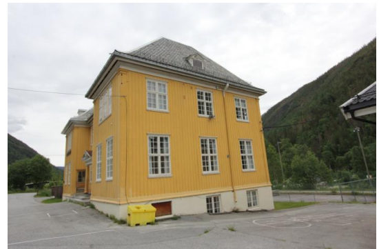
Utvendige malte fasader.
