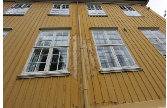
Utvendig vegg fasader
