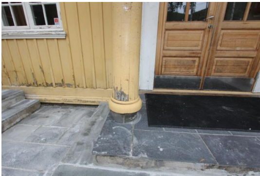
Trappeløsning med skifer heller.
