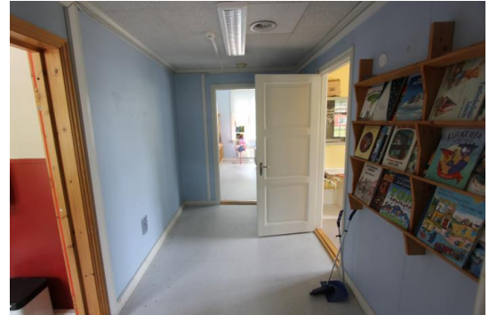
Gulv overlater med etasjeskille
