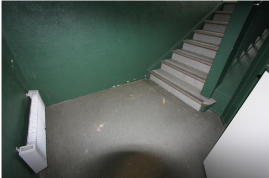
Gulvbelegg på støpt dekke.
