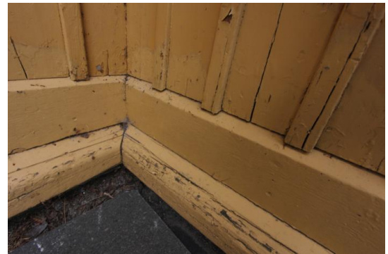
Trebrett med overgang til kledning.
