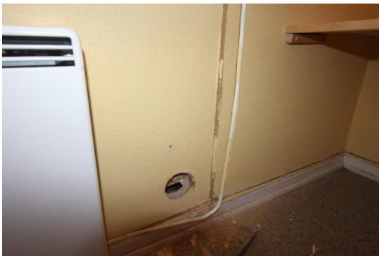
Hulltaking i vegg klasserom kjeller.
