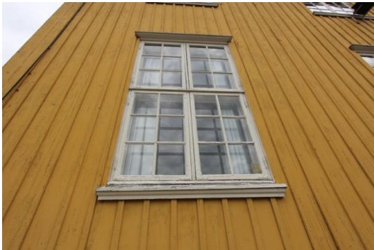
Vinduer registrert av variert type og alder.
