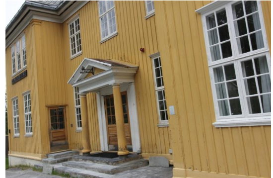
Utvendige malte fasader.
