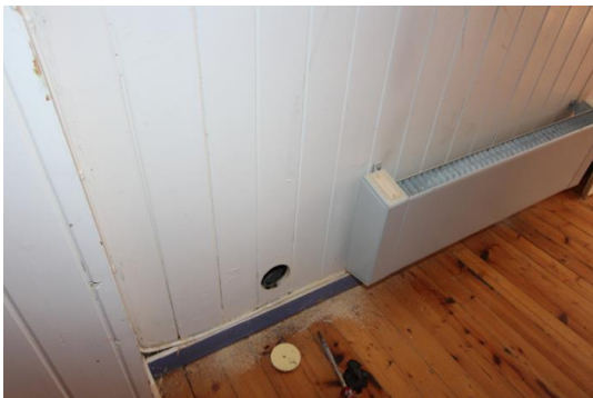
Hulltaking i vegg sløydsal kjeller.
