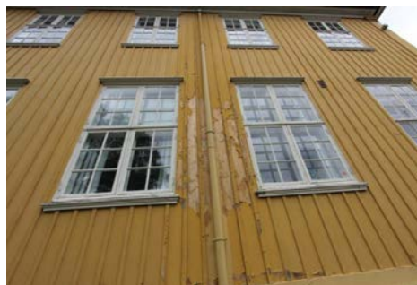
Utvendig vegg fasader
