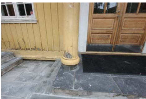
Trappeløsning med skifer heller.
