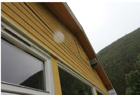
Utvendig kledning med behandling.
