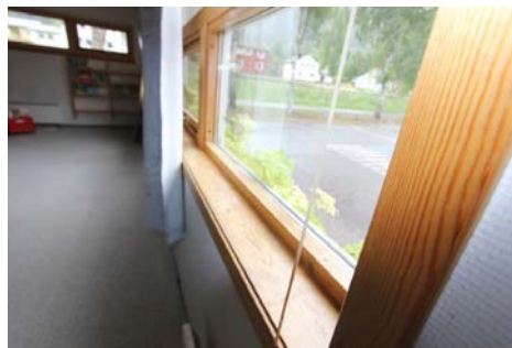
Innvendig vindu med foring.
