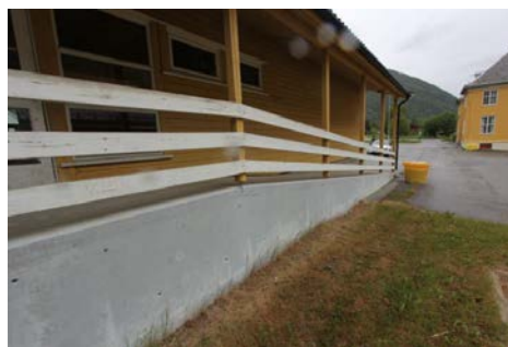
Betongstøpt rampe til hovedinngang.
