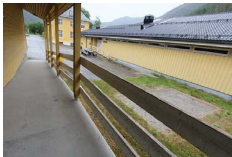
Betongstøpt rampe til hovedinngang.
