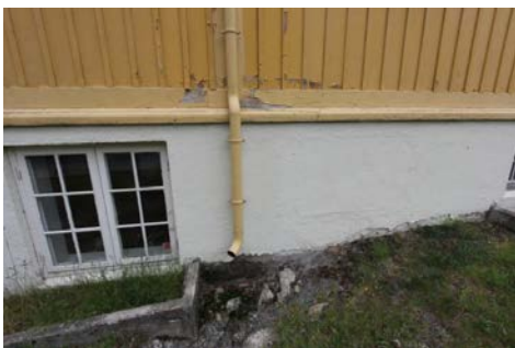
Taknedløp avsluttet over bakke.
