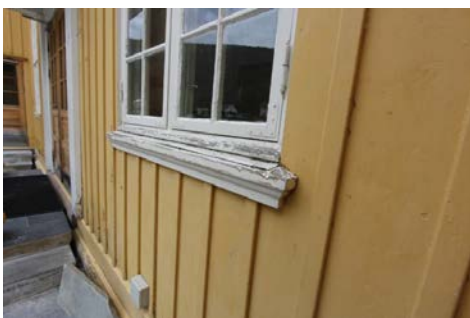
Værslitt behandling av vindusrammer.
