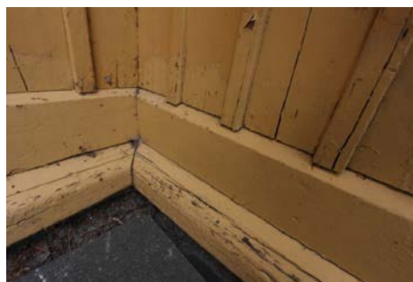
Trebrett med overgang til kledning.
