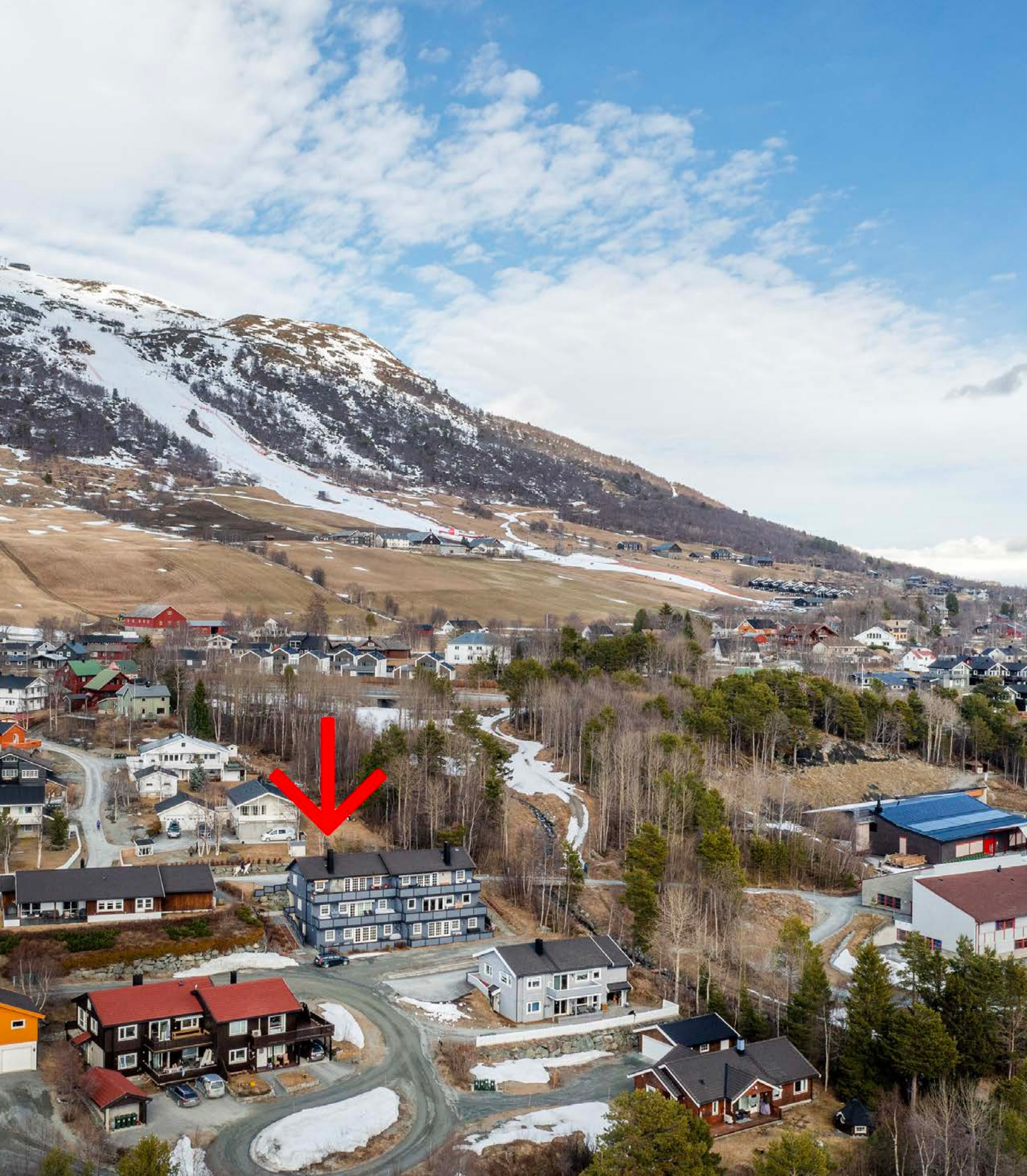
Sameiet Røtveivegen 29 består av seks leiligheter i terrassebygg like ved Oppdal videregående skole
