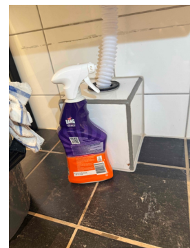
Bildet viser sprekke/skade i sokkelflis under servanten
