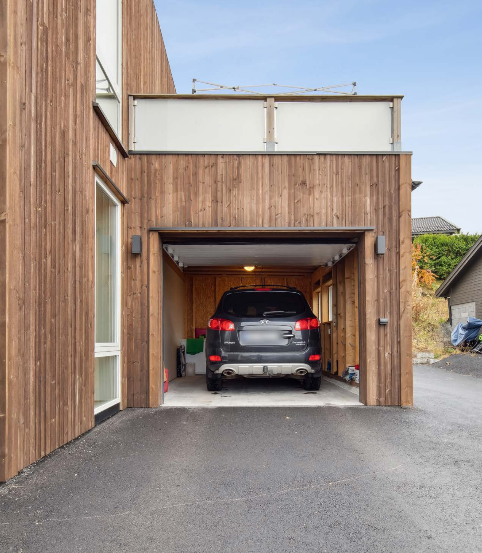
Garasje med bod i bakkant.
