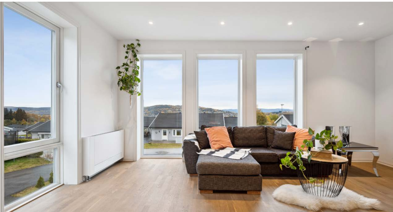
Boligen varmes opp med vannbåren varmeanlegg m/gulvvarme i hele 1. etasje og konvektor i stue i 2. etasje.
