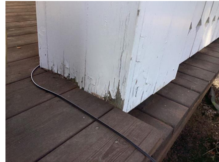
Eksempel på slitasje på hovedveranda.
