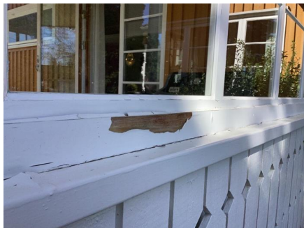
Eksempel på slitasje på hovedveranda.
