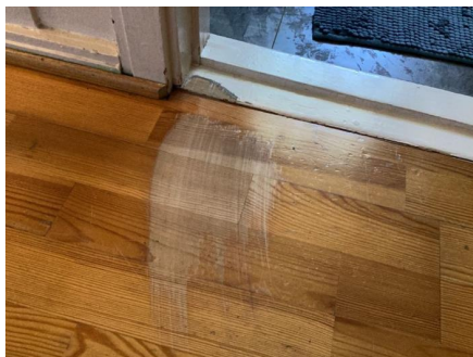
Eksempel på merker på gulv etter dør i 2. etasje.
