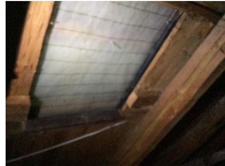
Det er utsparring i taktro som er overlatt med undertak av duk.
