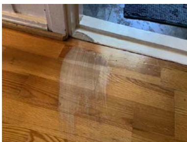
Eksempel på merker på gulv etter dør i 2. etasje.
