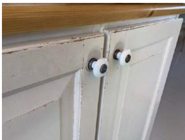
Eksempel på slitasje.
