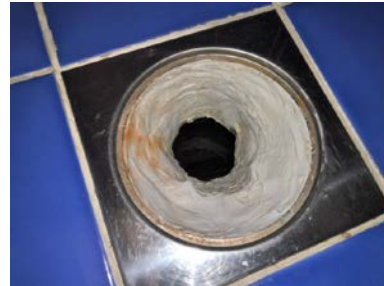
Sluk med lokalt smurt membran.
