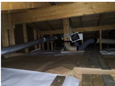
Loft over del av boligen hvor det er soverom bod og bad i 1. etasjen.
