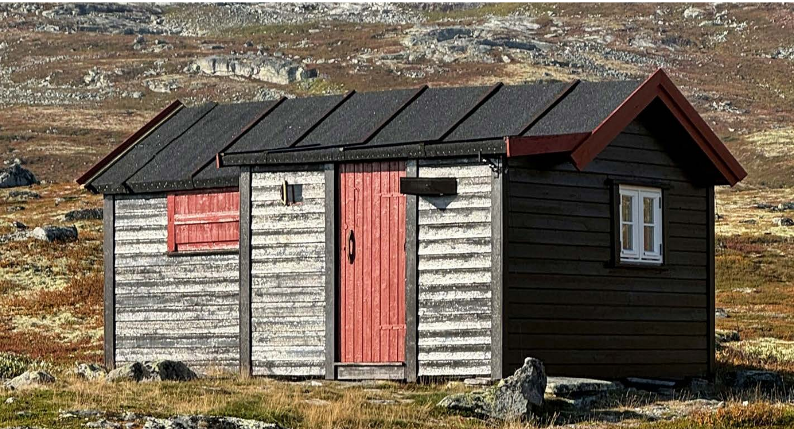
Enkel hytte oppført i reisverk på steingrunn
