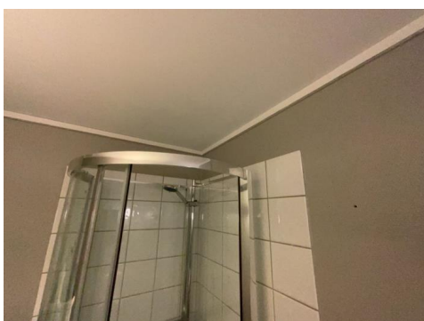
Del av vegg - tak.
