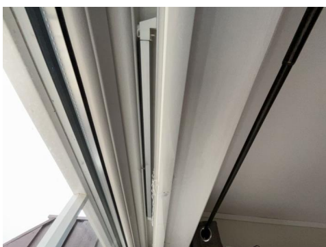
Eksempel på montert ventil i vindu.
