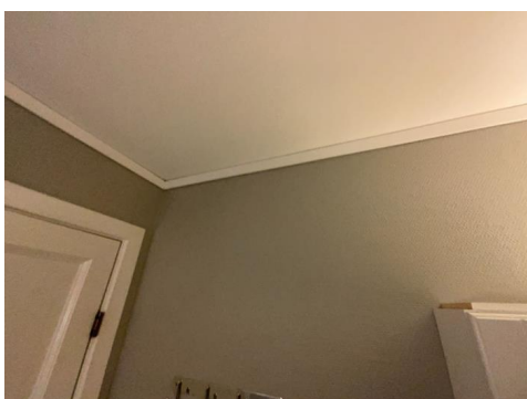
Del av vegg - tak.
