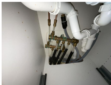
Del av rør til vann.
