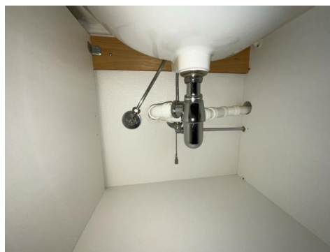
Del av rør til vann.
