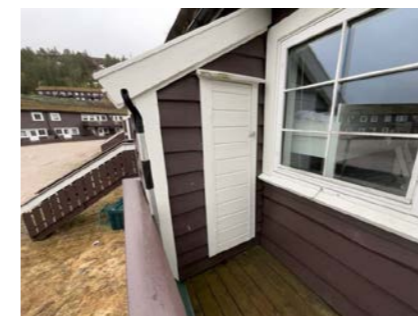
Dør inn til bod.
