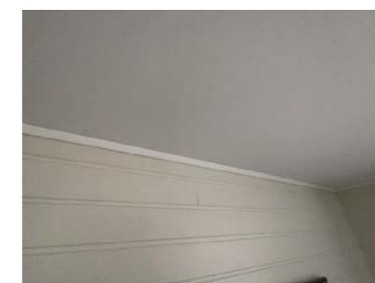
Del av vegg - tak.
