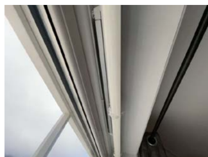
Eksempel på montert ventil i vindu.
