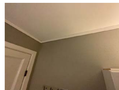
Del av vegg - tak.
