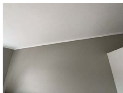
Del av vegg - tak.
