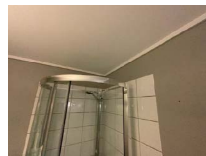
Del av vegg - tak.
