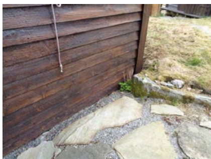
Liten avstand mellom bakke og bordkledning.
