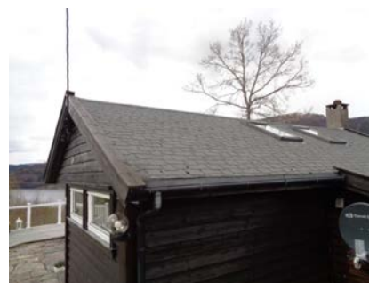
Yttertak tekket med shingel.
