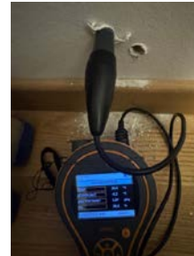
Måling av relativ luftfuktighet i vegg.
