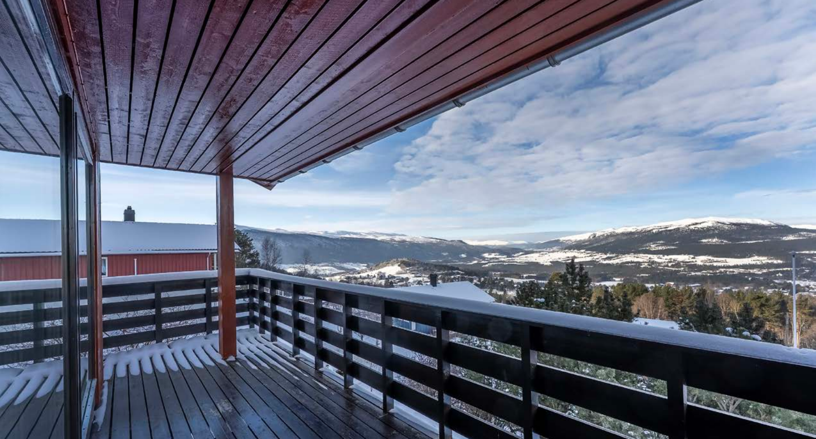
Veranda med overbygg (1. etasje)
