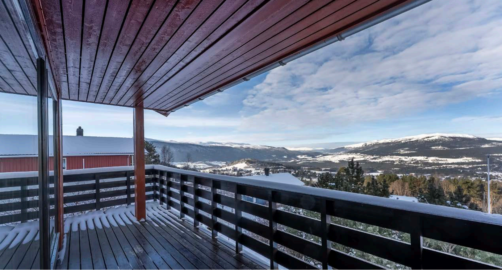
Veranda med overbygg (1. etasje)
