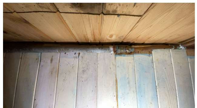
Vannrør er med vannrør av jern og med vannrør av kobber.
