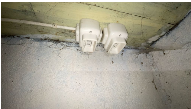
Koblinger for vaskemaskin og tørketrommel.
