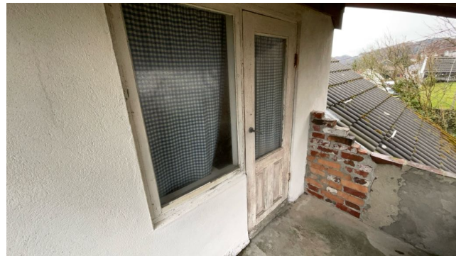
Boligen har malt balkongdør av tre med 1-lag glass fra byggeåret.
