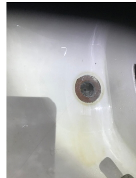
Vann renner tregt i vask på bad.
