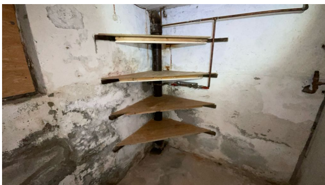
Synlig avløpsrør i kjeller.
