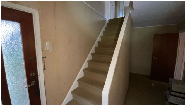
Trapp til 2. etasje.
