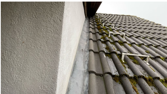
Taket har stige-trinn.
