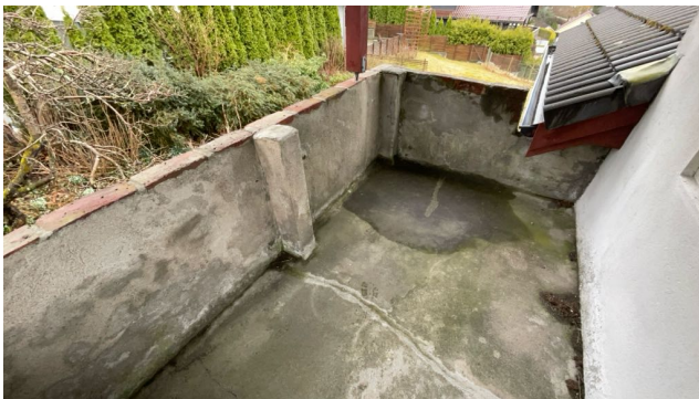
Gulv og rekkverk på altan.
