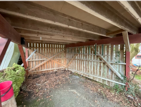
Carport med oversikt av konstruksjon.
