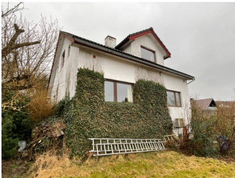
Store deler av boligen er dekket med Eføy med begrenset mulighet til å observere grunnmuren
