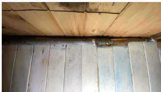
Vannrør er med vannrør av jern og med vannrør av kobber.
