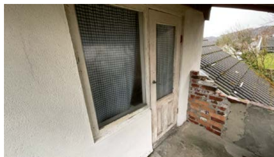
Boligen har malt balkongdør av tre med 1-lag glass fra byggeåret.
