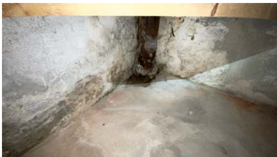
Avløpsrør i kjeller med stakeluke. Funksjon ble ikke testet.
