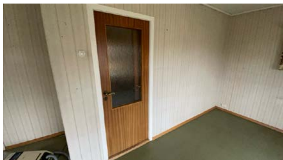
Innvendig dør fra stue til gang.
