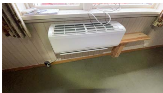
Inndel til varmepumpe er montert i stue
