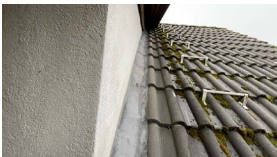
Taket har stigetrinn.
