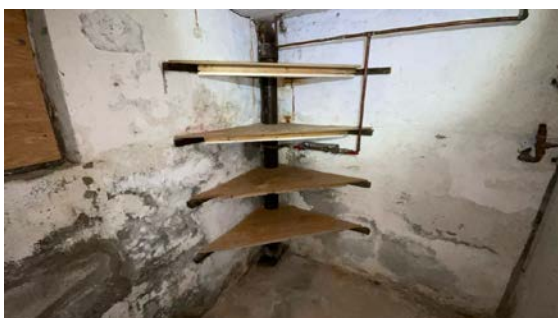
Synlig avløpsrør i kjeller.
