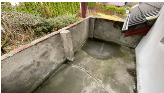
Gulv og rekkverk på altan.
