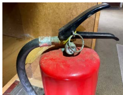
Boligen har brannslukningsapparat eldre enn 10 år
