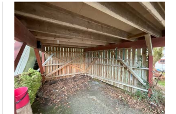
Carport med oversikt av konstruksjon.
