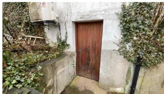
Kjellerdør er en tett dør av tre.
